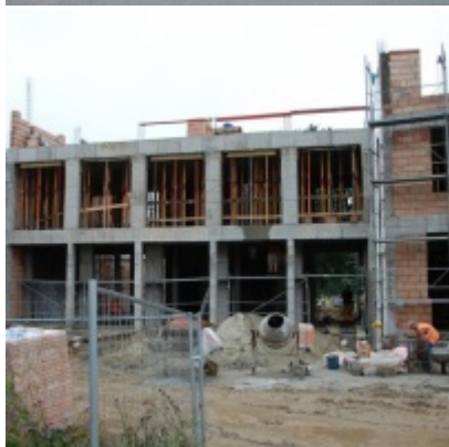
Budowa "Centrum Aktywizacji Zawodowej"
