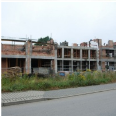
Budowa "Centrum Aktywizacji Zawodowej"
