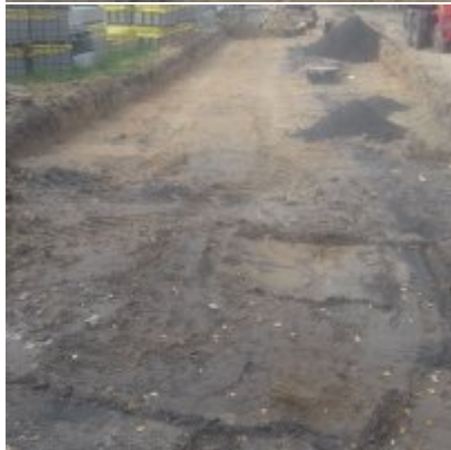
Prace budowlane na Al. Chopina w Zatorze
