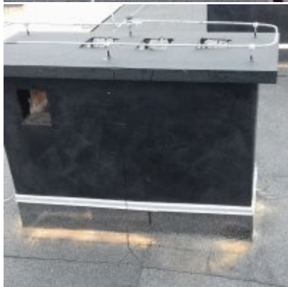
Remont dachu Szkoły podstawowej w Laskowej
