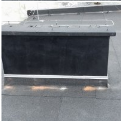
Remont dachu Szkoły podstawowej w Laskowej
