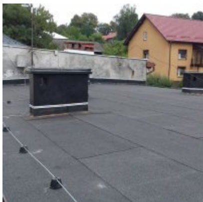
Remont dachu Szkoły podstawowej w Laskowej
