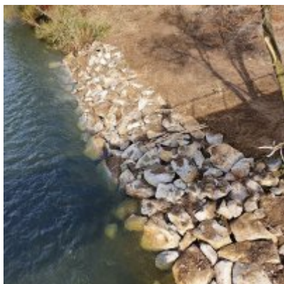
Zabezpieczenie brzegu odcinków Skawy w Gminie Zator
