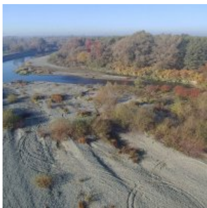
Zabezpieczenie brzegu odcinków Skawy w Gminie Zator
