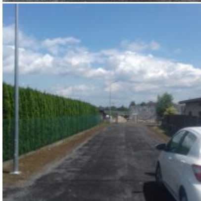
Modernizacja ul. Grunwaldzkiej
