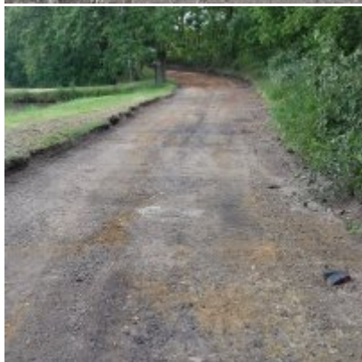
Modernizacja drogi wewnętrznej
