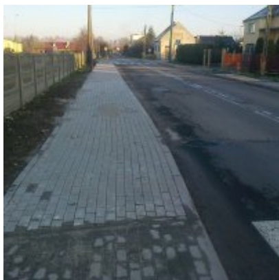
Budowa prawostronnego chodnika wzdłuż ul. Jana Pawła II w Zatorze o długości ok. 40 mb
