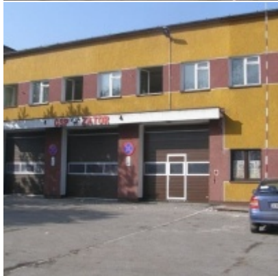
Przebudowa i modernizacja remizy strażackiej w Zatorze
