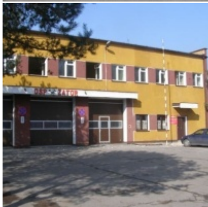
Przebudowa i modernizacja remizy strażackiej w Zatorze
