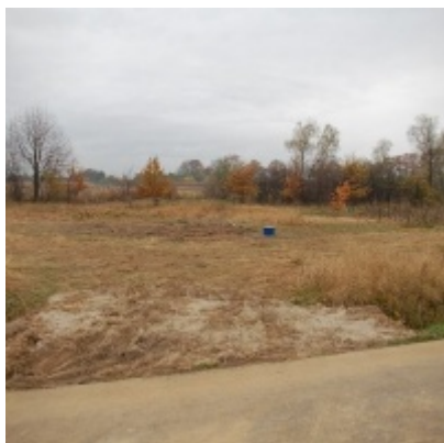
Nowe ujęcie wody pitnej
