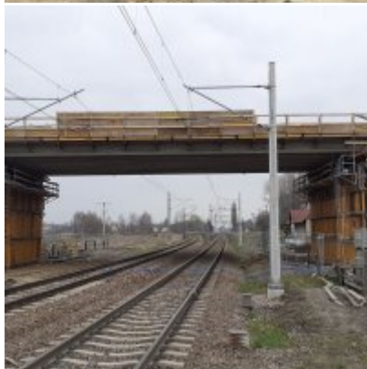
Postęp prac na budowie obwodnicy Podolsza DW 781
