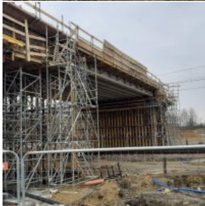
Postęp prac na budowie obwodnicy Podolsza DW 781
