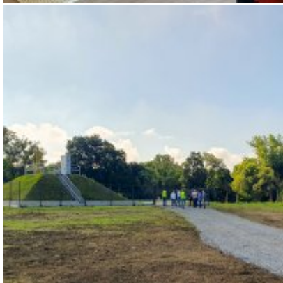
Budowa nowego ujęcia wody z rzeki Skawy.
