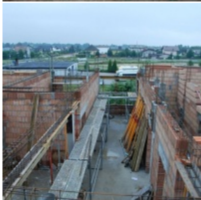
Budowa "Centrum Aktywizacji Zawodowej"
