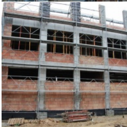
Budowa "Centrum Aktywizacji Zawodowej"
