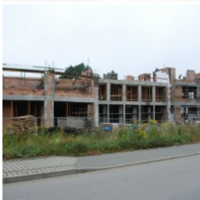
Budowa "Centrum Aktywizacji Zawodowej"
