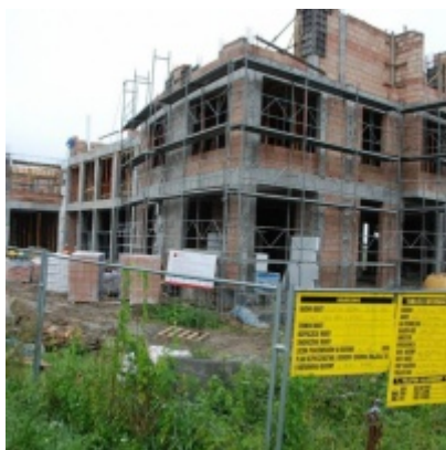
Budowa "Centrum Aktywizacji Zawodowej"
