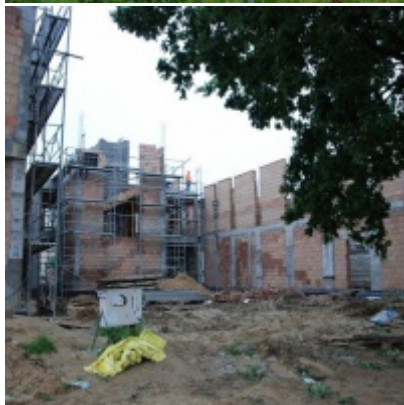
Budowa "Centrum Aktywizacji Zawodowej"
