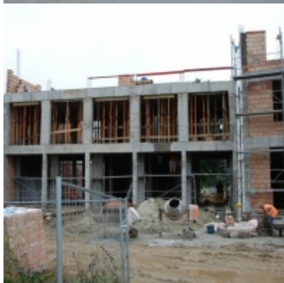
Budowa "Centrum Aktywizacji Zawodowej"
