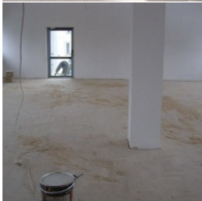
Modernizacja OSP w Zatorze
