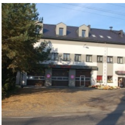
Modernizacja OSP w Zatorze
