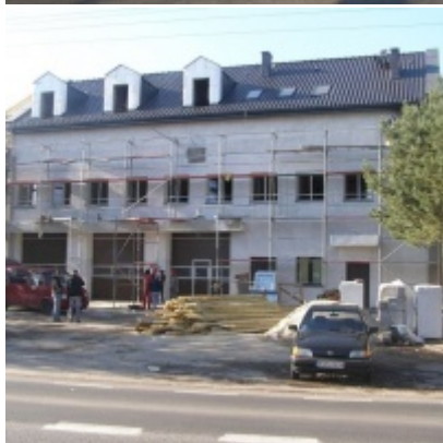
Modernizacja OSP w Zatorze
