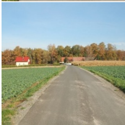
Przebudowa dróg w Gminie Zator
