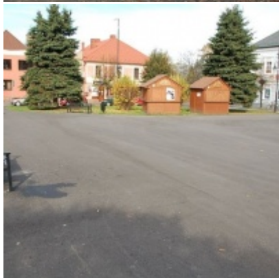
Przebudowa dróg w Gminie Zator
