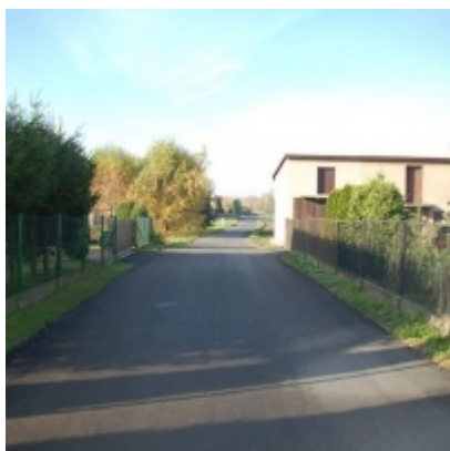
Przebudowa dróg w Gminie Zator
