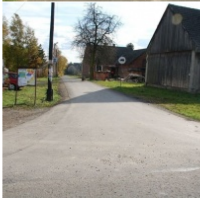
Przebudowa dróg w Gminie Zator
