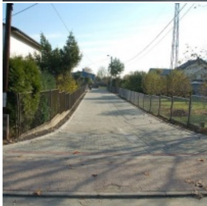
Przebudowa dróg w Gminie Zator
