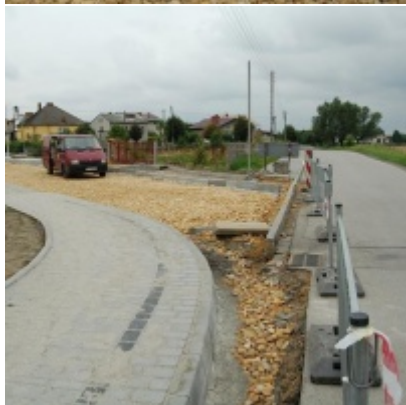
Kompleksowa modernizacja ciągu komunikacyjnego - ul. J. Słowackiego
