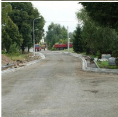
Kompleksowa modernizacja ciągu komunikacyjnego - ul. J. Słowackiego
