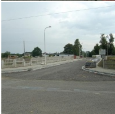
Kompleksowa modernizacja ciągu komunikacyjnego - ul. J. Słowackiego
