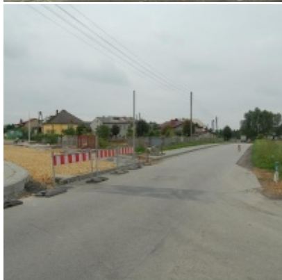
Kompleksowa modernizacja ciągu komunikacyjnego - ul. J. Słowackiego
