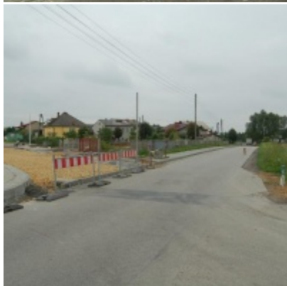
Kompleksowa modernizacja ciągu komunikacyjnego - ul. J. Słowackiego
