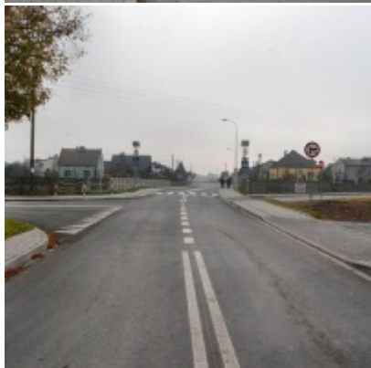
Kompleksowa modernizacja ciągu komunikacyjnego - ul. J. Słowackiego
