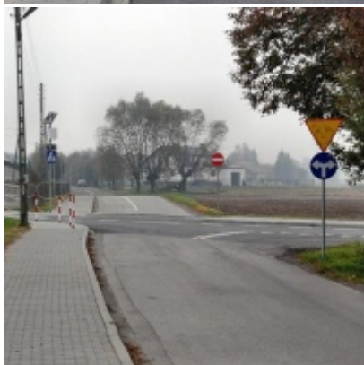
Kompleksowa modernizacja ciągu komunikacyjnego - ul. J. Słowackiego
