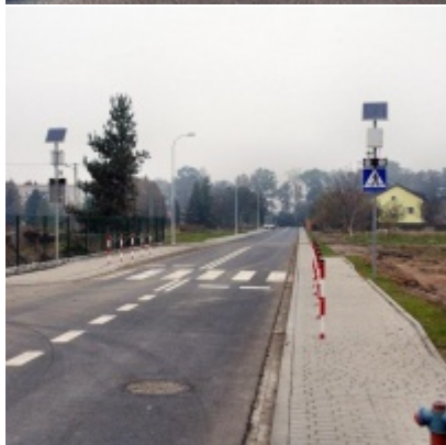
Kompleksowa modernizacja ciągu komunikacyjnego - ul. J. Słowackiego
