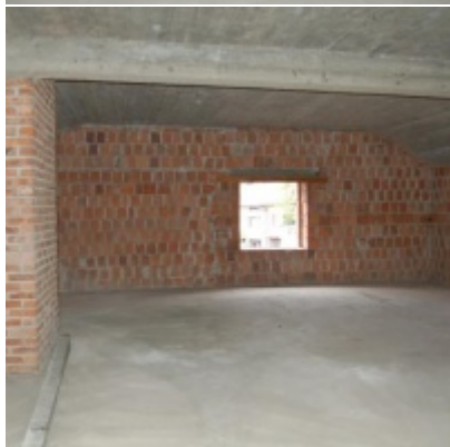
Rozbudowa i remont budynków Urzędu Miejskiego 2008/2010
