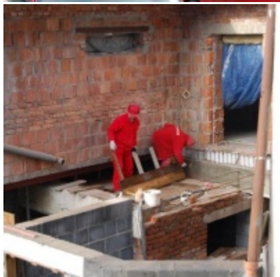
Rozbudowa i remont budynków Urzędu Miejskiego 2008/2010
