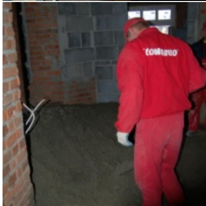
Rozbudowa i remont budynków Urzędu Miejskiego 2008/2010
