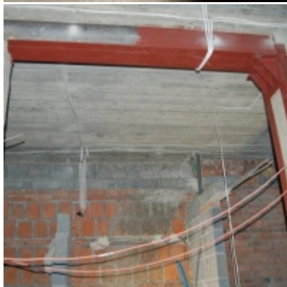
Rozbudowa i remont budynków Urzędu Miejskiego 2008/2010
