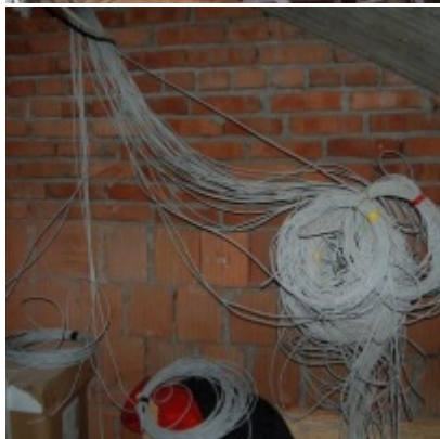
Rozbudowa i remont budynków Urzędu Miejskiego 2008/2010
