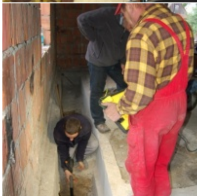
Rozbudowa i remont budynków Urzędu Miejskiego 2008/2010
