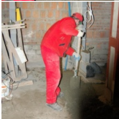
Rozbudowa i remont budynków Urzędu Miejskiego 2008/2010
