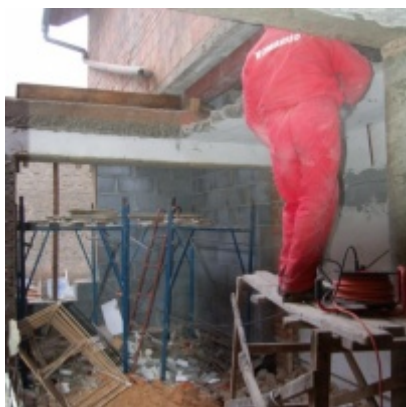
Rozbudowa i remont budynków Urzędu Miejskiego 2008/2010
