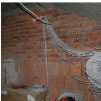
Rozbudowa i remont budynków Urzędu Miejskiego 2008/2010
