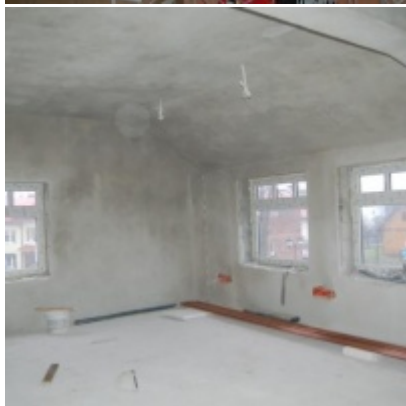
Rozbudowa i remont budynków Urzędu Miejskiego 2008/2010
