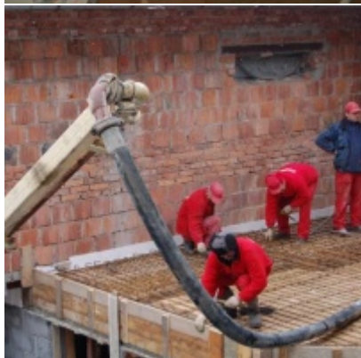
Rozbudowa i remont budynków Urzędu Miejskiego 2008/2010
