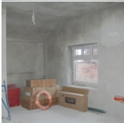
Rozbudowa i remont budynków Urzędu Miejskiego 2008/2010
