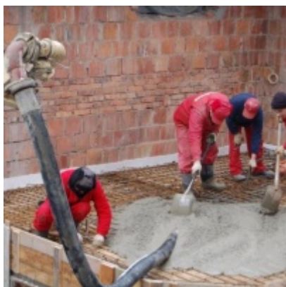
Rozbudowa i remont budynków Urzędu Miejskiego 2008/2010
