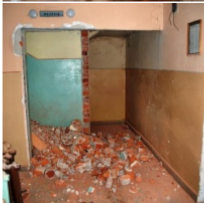
Rozbudowa i remont Regionalnego Ośrodka Kultury
