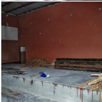
Rozbudowa i remont Regionalnego Ośrodka Kultury
