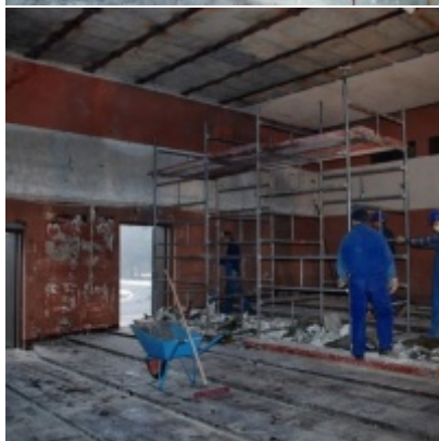
Rozbudowa i remont Regionalnego Ośrodka Kultury
