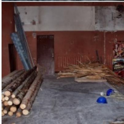
Rozbudowa i remont Regionalnego Ośrodka Kultury
