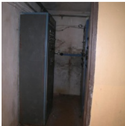
Rozbudowa i remont Regionalnego Ośrodka Kultury
