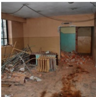
Rozbudowa i remont Regionalnego Ośrodka Kultury
