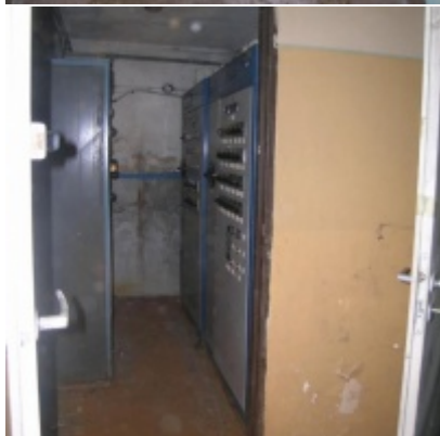
Rozbudowa i remont Regionalnego Ośrodka Kultury
