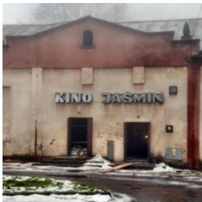
Rozbudowa i remont Regionalnego Ośrodka Kultury
