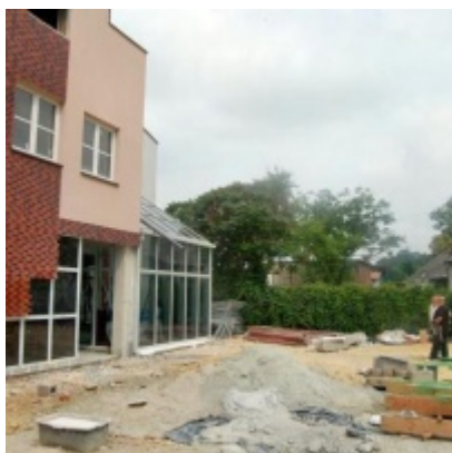
Rozbudowa i remont Regionalnego Ośrodka Kultury
