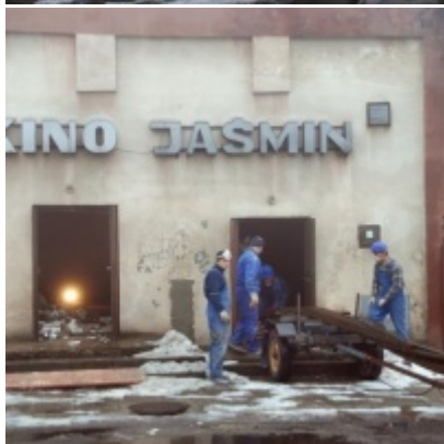
Rozbudowa i remont Regionalnego Ośrodka Kultury
