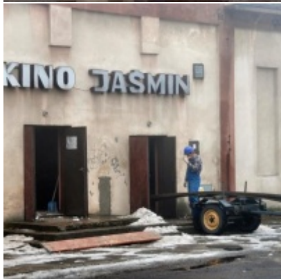
Rozbudowa i remont Regionalnego Ośrodka Kultury
