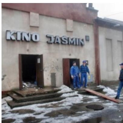
Rozbudowa i remont Regionalnego Ośrodka Kultury
