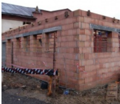
Rozbudowa i remont Regionalnego Ośrodka Kultury
