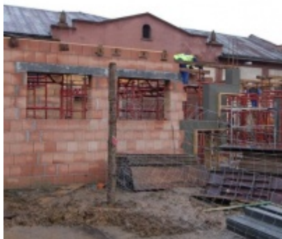
Rozbudowa i remont Regionalnego Ośrodka Kultury
