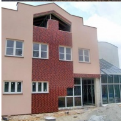
Rozbudowa i remont Regionalnego Ośrodka Kultury
