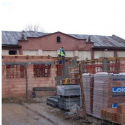
Rozbudowa i remont Regionalnego Ośrodka Kultury
