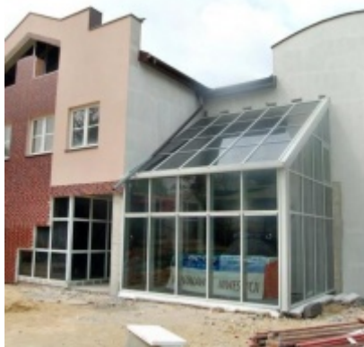
Rozbudowa i remont Regionalnego Ośrodka Kultury
