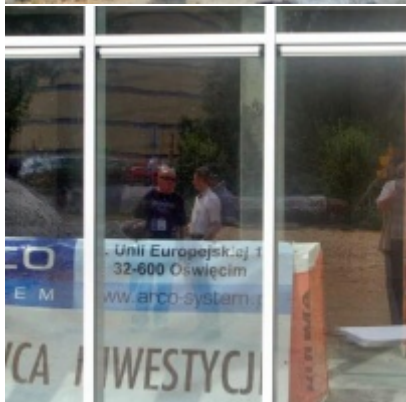
Rozbudowa i remont Regionalnego Ośrodka Kultury
