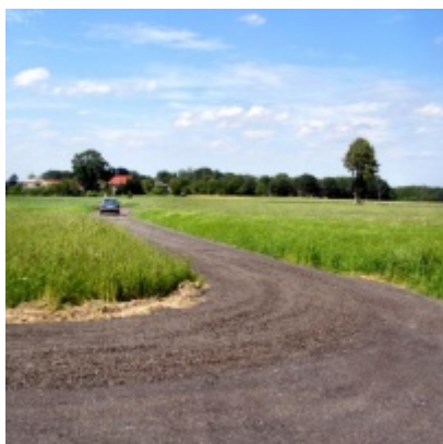
Inwestycje drogowe realizowane w 2009 r. - Graboszyce
