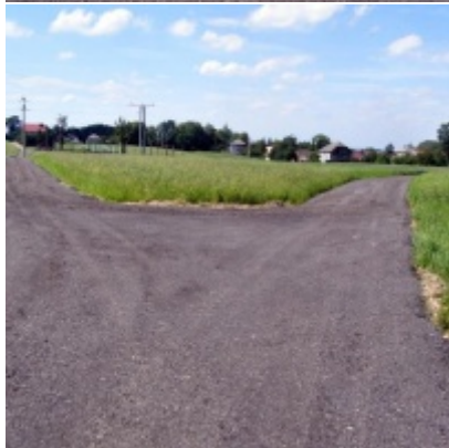
Inwestycje drogowe realizowane w 2009 r. - Graboszyce
