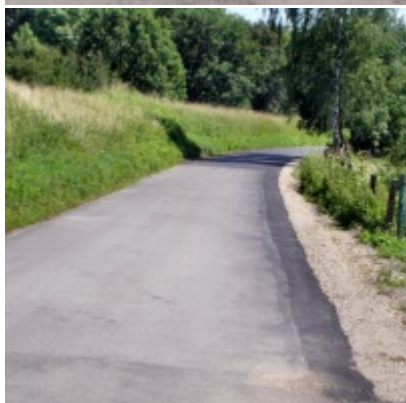
Inwestycje drogowe realizowane w 2009 r. - Wałowa
