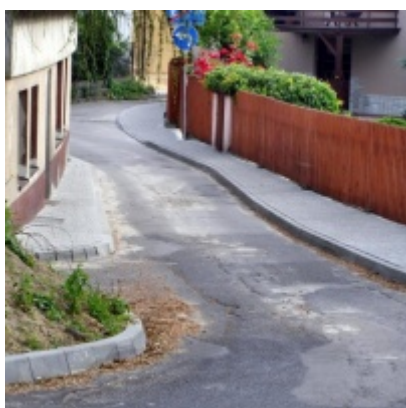
Inwestycje drogowe realizowane w 2009 r. - Szkolna
