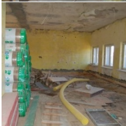
Przebudowa i modernizacja remizy strażackiej w Zatorze
