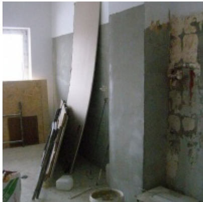
Przebudowa i modernizacja remizy strażackiej w Zatorze
