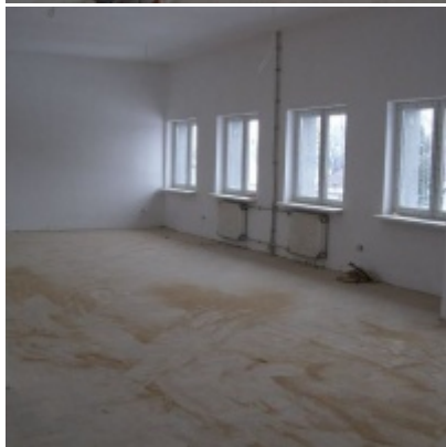
Przebudowa i modernizacja remizy strażackiej w Zatorze
