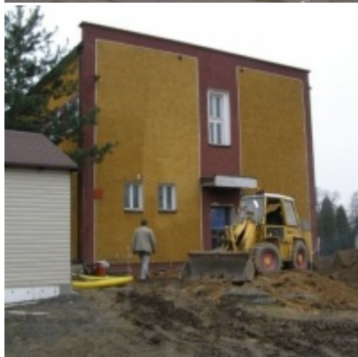
Przebudowa i modernizacja remizy strażackiej w Zatorze
