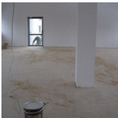
Przebudowa i modernizacja remizy strażackiej w Zatorze
