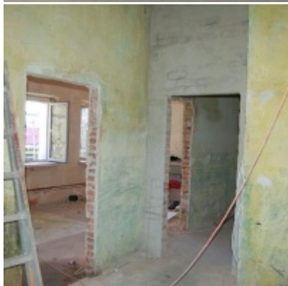
Przebudowa i modernizacja remizy strażackiej w Zatorze
