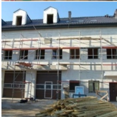
Przebudowa i modernizacja remizy strażackiej w Zatorze
