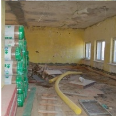
Przebudowa i modernizacja remizy strażackiej w Zatorze
