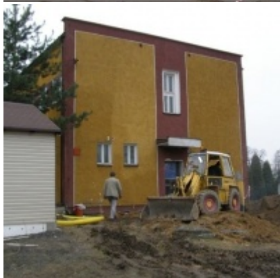
Przebudowa i modernizacja remizy strażackiej w Zatorze
