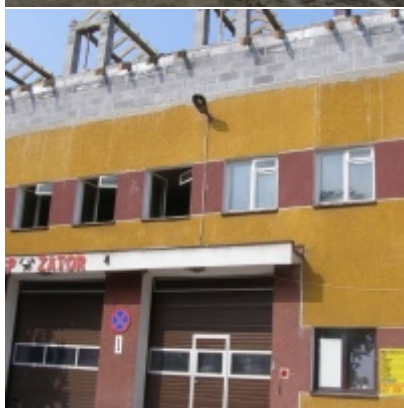
Przebudowa i modernizacja remizy strażackiej w Zatorze
