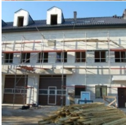
Przebudowa i modernizacja remizy strażackiej w Zatorze
