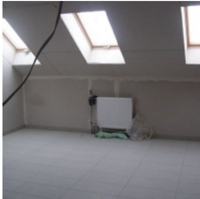
Przebudowa i modernizacja remizy strażackiej w Zatorze
