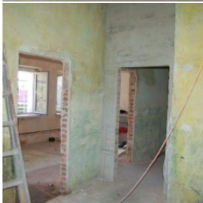
Przebudowa i modernizacja remizy strażackiej w Zatorze
