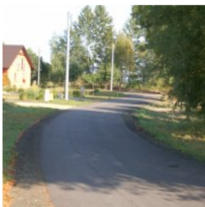
2. Przebudowa ul. Jagodowej w Podolszu
