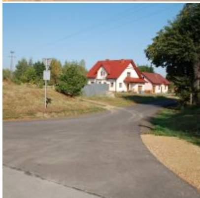
2. Przebudowa ul. Jagodowej w Podolszu
