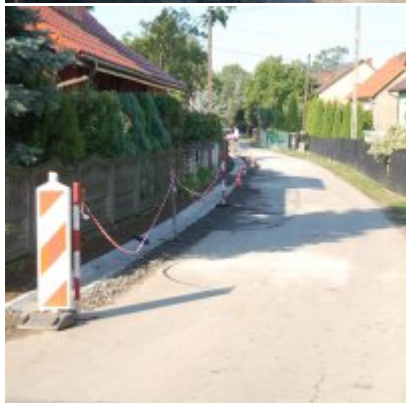
Budowa odwodnienia ul. Gimnazjalnej w Podolszu
