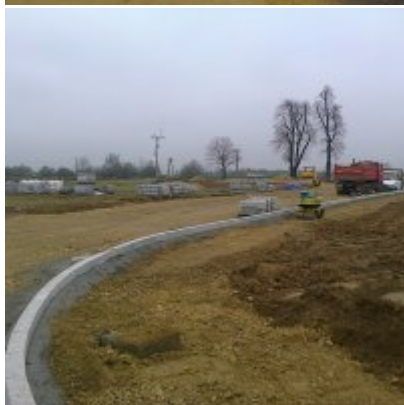
2016-04-13 Bieżący stan prac przy budowie ronda.
