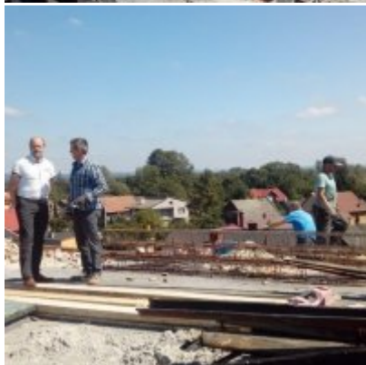
MODERNIZACJA DACHU NA BUDYNKU ZSO w PODOLSZU
