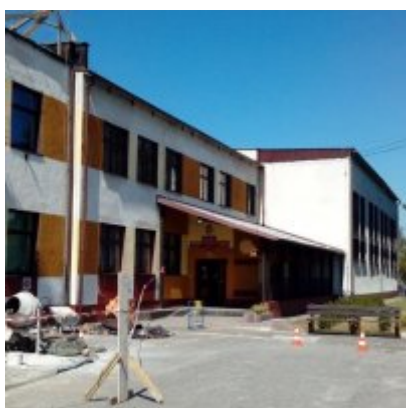
MODERNIZACJA DACHU NA BUDYNKU ZSO w PODOLSZU
