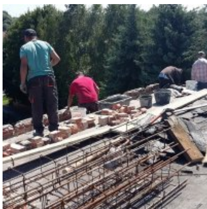
MODERNIZACJA DACHU NA BUDYNKU ZSO w PODOLSZU
