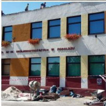
MODERNIZACJA DACHU NA BUDYNKU ZSO w PODOLSZU
