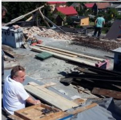
MODERNIZACJA DACHU NA BUDYNKU ZSO w PODOLSZU
