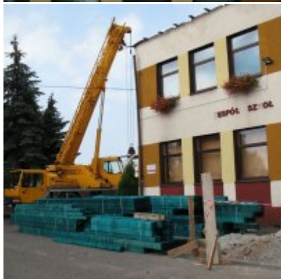
Remont dachu w ZSO Podolsze
