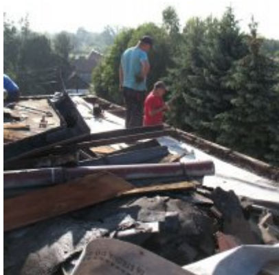
Remont dachu w ZSO Podolsze
