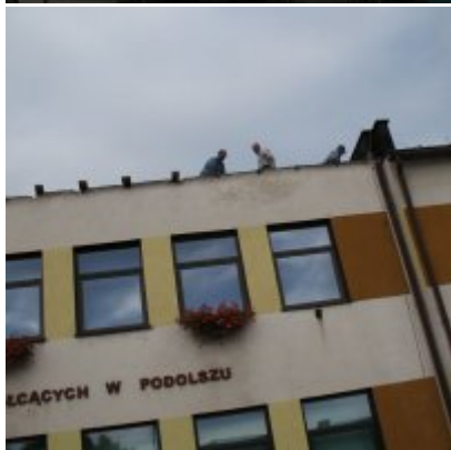
Remont dachu w ZSO Podolsze
