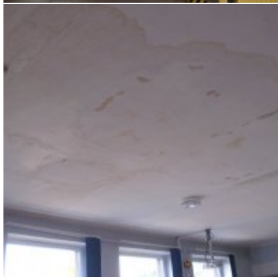
Remont dachu w ZSO Podolsze
