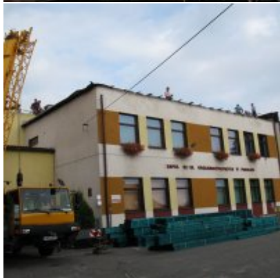
Remont dachu w ZSO Podolsze
