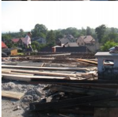
Remont dachu w ZSO Podolsze
