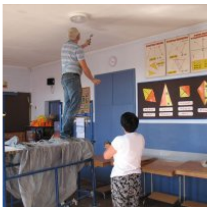
Remont dachu w ZSO Podolsze
