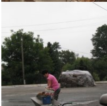
Remont dachu w ZSO Podolsze
