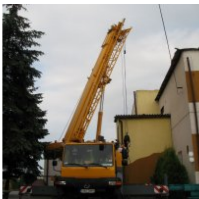
Remont dachu w ZSO Podolsze
