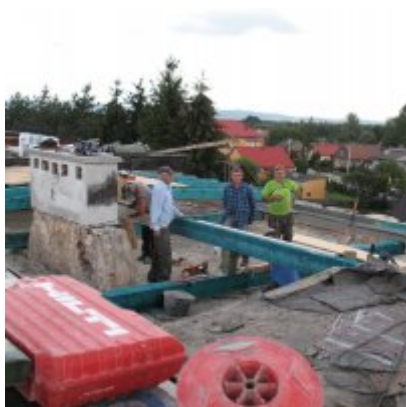
Remont dachu w ZSO Podolsze
