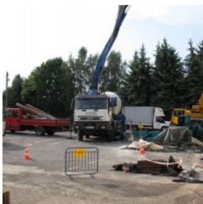
Remont dachu w ZSO Podolsze
