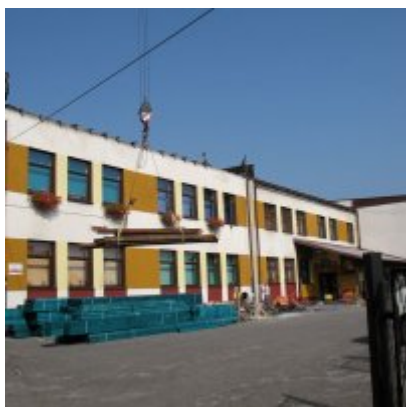
Remont dachu w ZSO Podolsze
