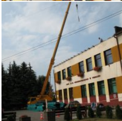
Remont dachu w ZSO Podolsze
