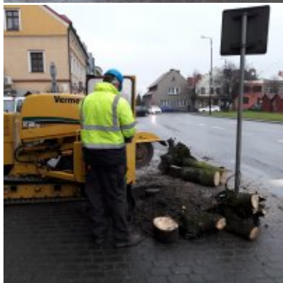
Wycinka drzew w obrębie Zatorskiego rynku
