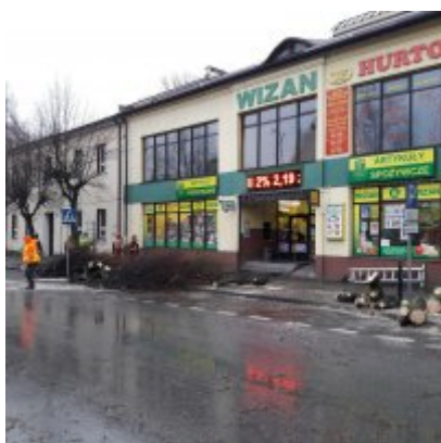
Wycinka drzew w obrębie Zatorskiego rynku
