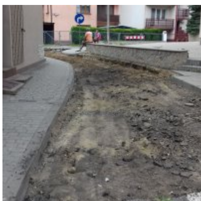
Remont ulicy Szkolnej w Zatorze
