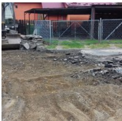
Remont ulicy Szkolnej w Zatorze
