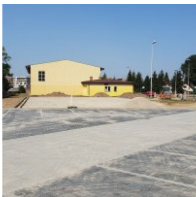
Budowa miejsc postojowych dla samochodów w Zatorze
