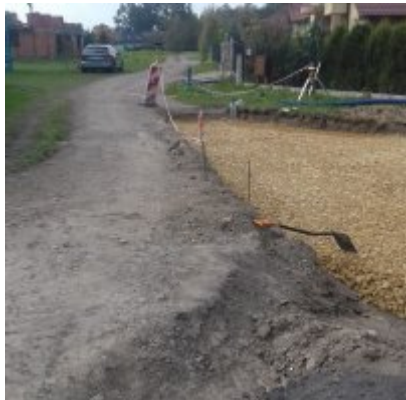
Prace budowlane na Al. Chopina w Zatorze
