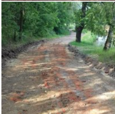
Modernizacja drogi wewnętrznej
