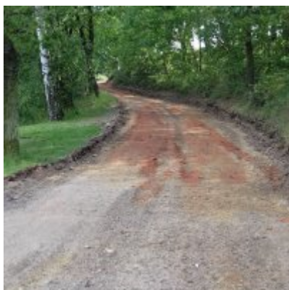
Modernizacja drogi wewnętrznej
