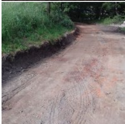
Modernizacja drogi wewnętrznej
