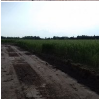
Modernizacja drogi wewnętrznej
