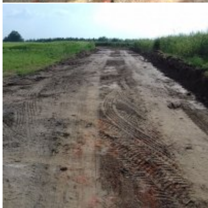
Modernizacja drogi wewnętrznej
