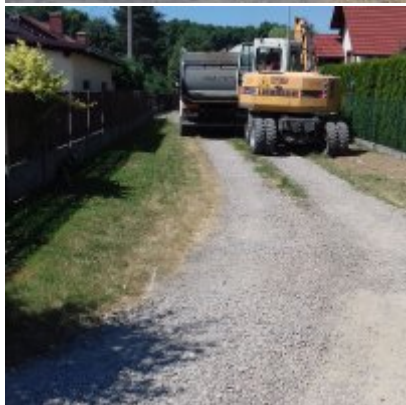
Rozpoczęto prace modernizacyjne na ul. Grunwaldzkiej
