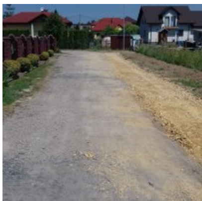
Rozpoczęto prace modernizacyjne na ul. Grunwaldzkiej
