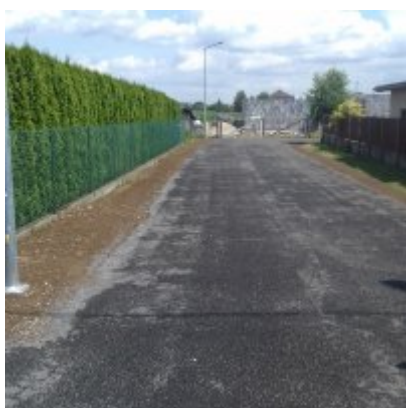
Modernizacja ul. Grunwaldzkiej
