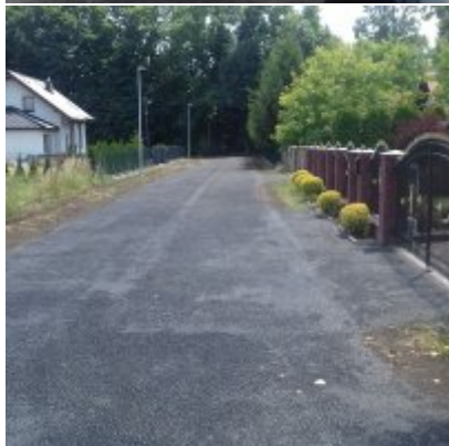
Modernizacja ul. Grunwaldzkiej
