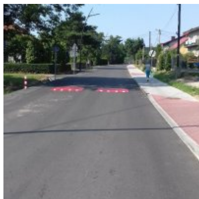
Droga powiatowa w Graboszycach już po modernizacji
