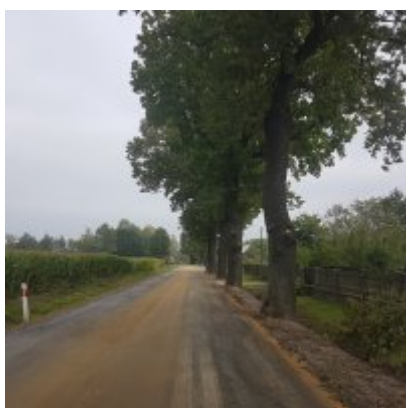
Praca wre - modernizacja drogi wojewódzkiej.
