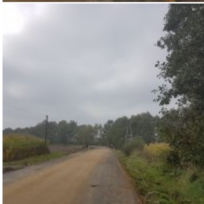
Praca wre - modernizacja drogi wojewódzkiej.
