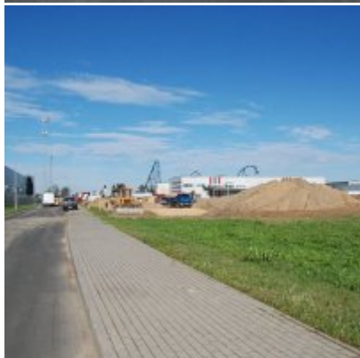
Fotogaleria Zatorskiej Strefy Aktywności Gospodarczej
