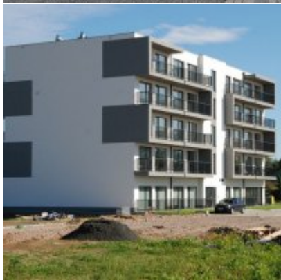
Fotogaleria Zatorskiej Strefy Aktywności Gospodarczej
