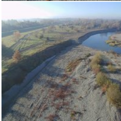
Zabezpieczenie brzegu odcinków Skawy w Gminie Zator
