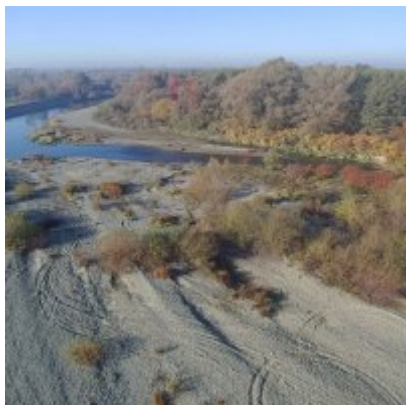
Zabezpieczenie brzegu odcinków Skawy w Gminie Zator
