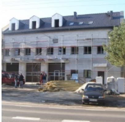
Modernizacja OSP w Zatorze
