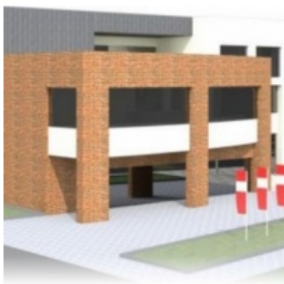
Budowa "Centrum Aktywizacji Zawodowej"
