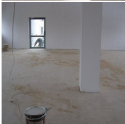
Modernizacja OSP w Zatorze
