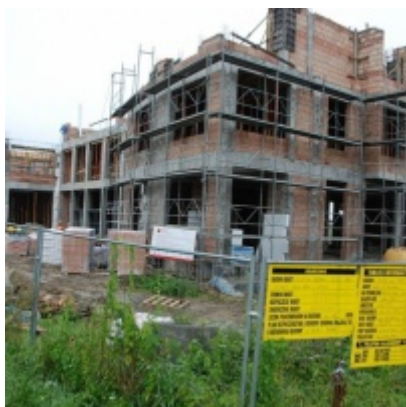
Budowa "Centrum Aktywizacji Zawodowej"
