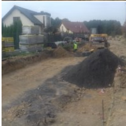
Prace budowlane na Al. Chopina w Zatorze
