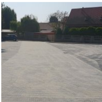
Budowa miejsc postojowych dla samochodów w Zatorze
