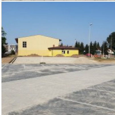
Budowa miejsc postojowych dla samochodów w Zatorze
