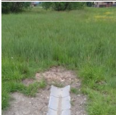
Rozpoczęcie robót dróg
