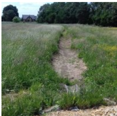
Rozpoczęcie robót dróg
