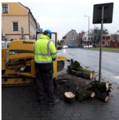
Wycinka drzew w obrębie Zatorskiego rynku
