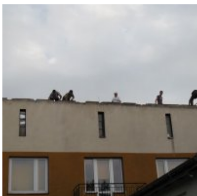
Remont dachu w ZSO Podolsze
