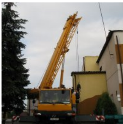
Remont dachu w ZSO Podolsze
