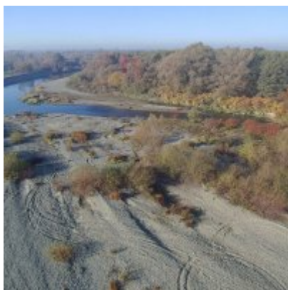
Zabezpieczenie brzegu odcinków Skawy w Gminie Zator
